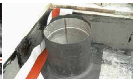
Einfassungen lassen sich in das Band vulkanisieren
