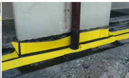
Einfassungen lassen sich problemlos ins MIGUPREN FlamLINE Fugenband einvulkanisieren
