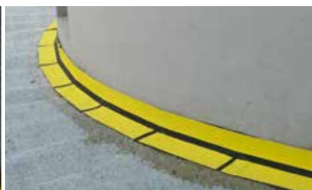
Optimale Anpassung von MIGUPREN FlamLINE an Gebäudestrukturen sichern die Dichtigkeit des Bauwerkes
