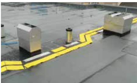
Spezielle Blechübergangs- und Zwischenstücke ermöglichen den Anschluss an Dachdeckerarbeiten
