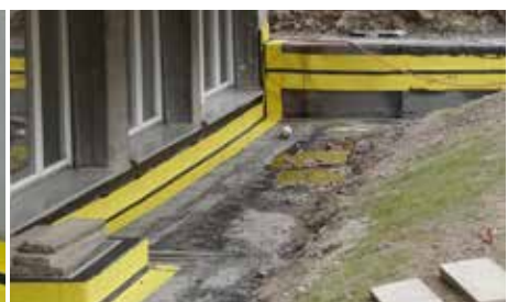
Durchgängige MIGUPREN FlamLINE Fugenabdichtung über zahlreiche Ecken und Höhenunterschiede
