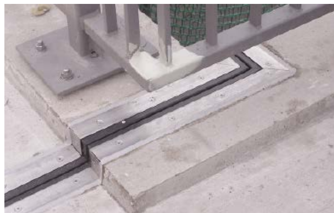
Remont mostu Eilenburg
